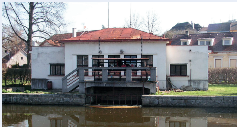
Malá vodní elektrárna Jindřichův Hradec: příklad historického využití energetického potenciálu vody
