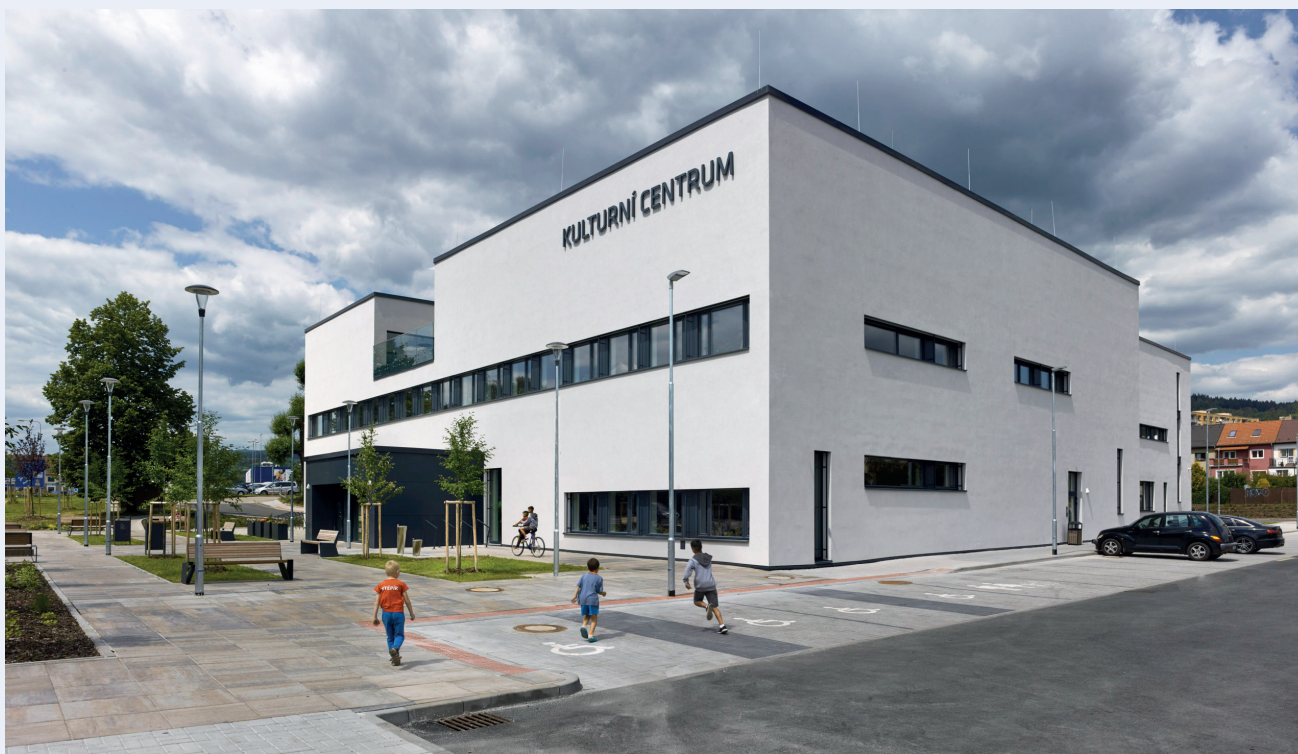
Energeticky pasivní kulturní dům v Klášterci nad Ohří
