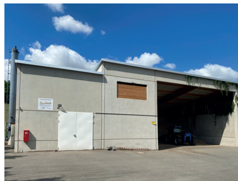
Výtopna na biomasu (dřevní štěpku) v durynské obci Bechstedt
