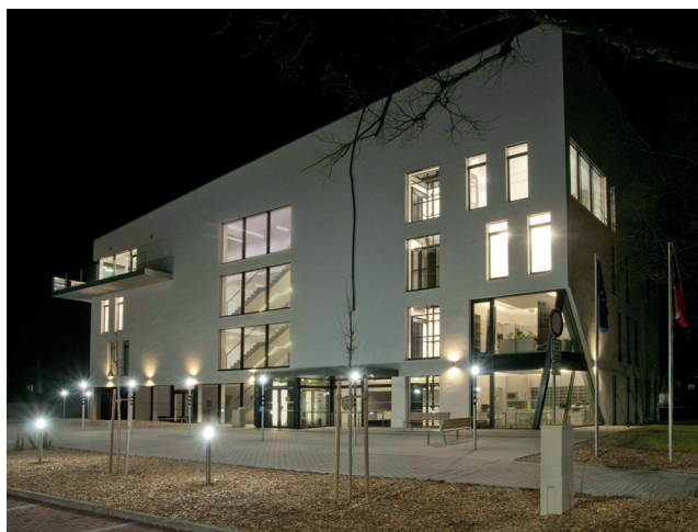
Pasivní budova ZUŠ Holice
