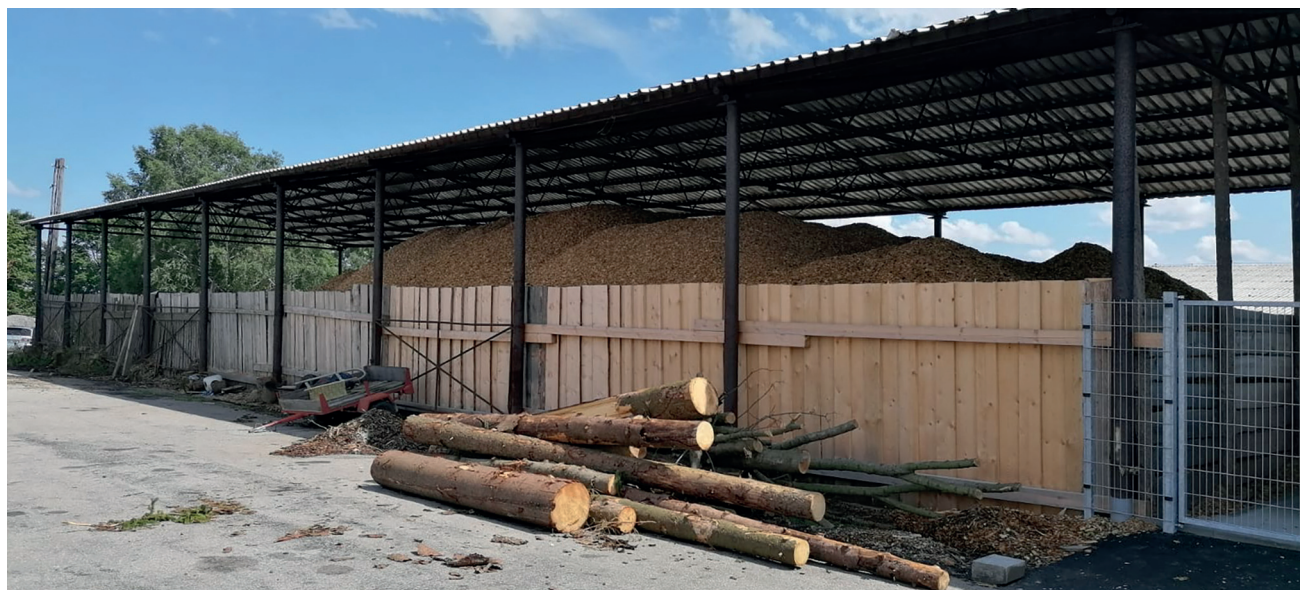
Skladování štěpky pro obecní biokotelnu v obci Svatý Jan nad Malší
