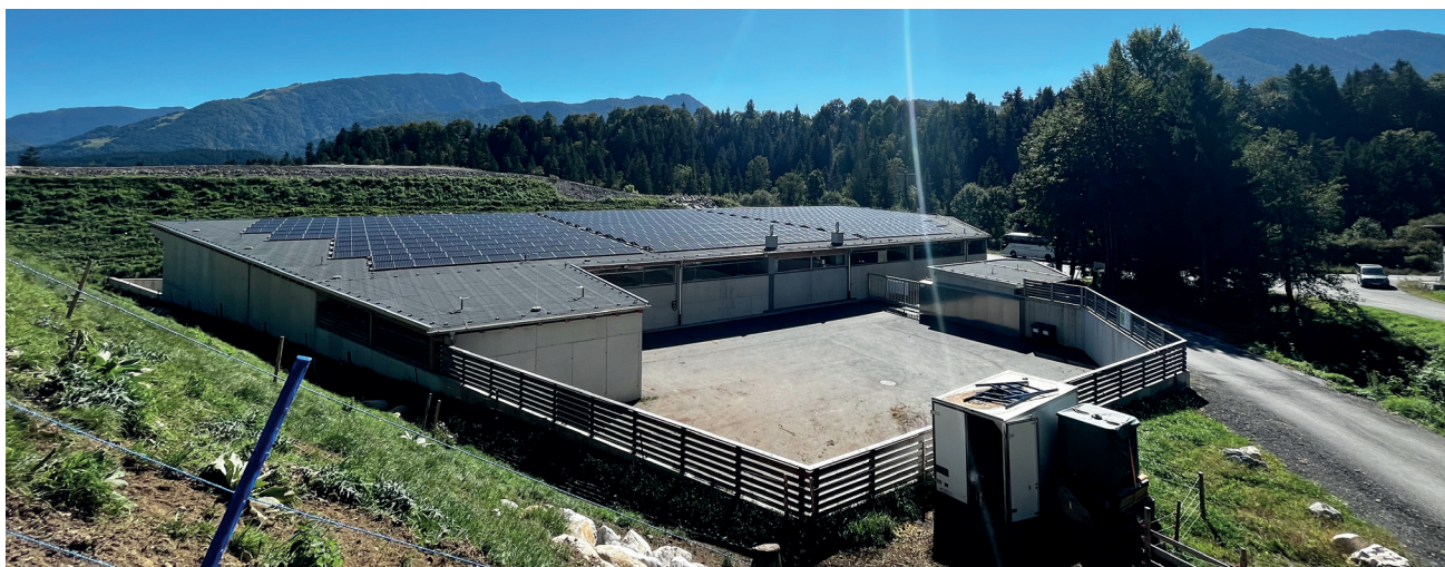
Dobrá praxe rakouské obce Kössen. Na střechu sběrného dvora instalovala obec vlastní (tj. komunální) fotovoltaickou elektrárnu, z níž napájí elektřinou obecní budovy i některé bytové domy.
