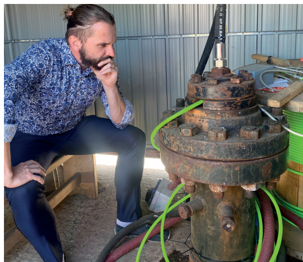
Vyústění dvoukilometrového zkušebního geotermálního vrtu v litoměřickém výzkumném centru Ringen
