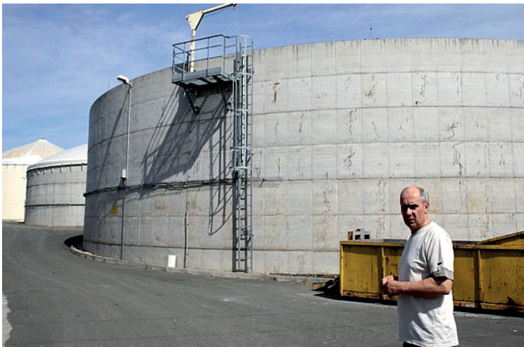
Odpadová bioplynová stanice Kněžice a její duchovní otec, legenda české obecní energetiky Milan Kazda (starosta obce Kněžice)
