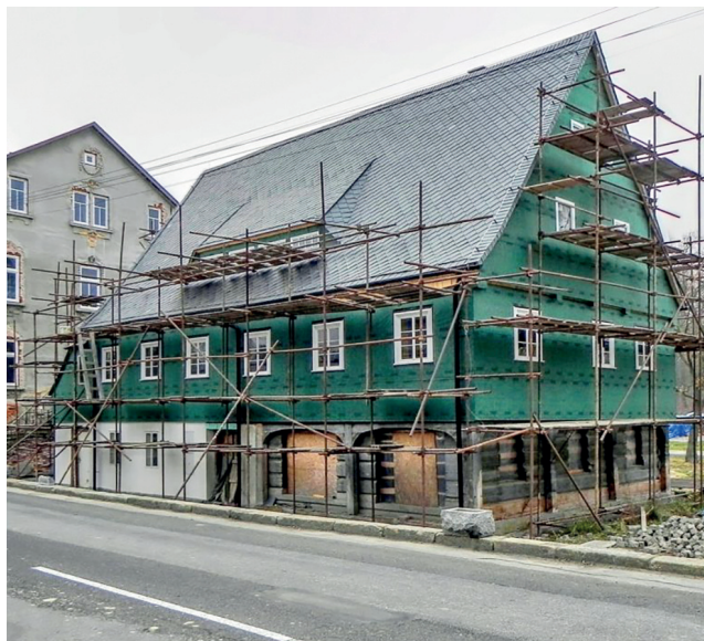
Oprava a energetická optimalizace památkově chráněného podstávkového domu v obci Lipová u Šluknova
