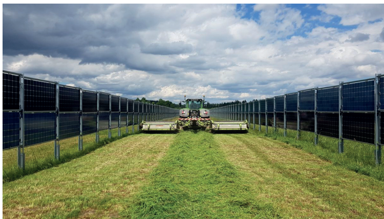
Ilustrativní fotografie bifaciálních solárních panelů a dvojího využití půdy, tzv. agrivoltaiky
