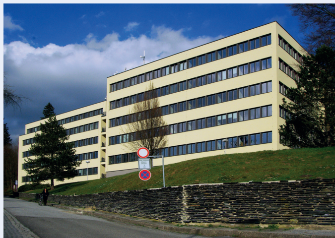
Objekt správy městského majetku města Jeseník – budova, která prošla optimalizací v rámci metody EPC
